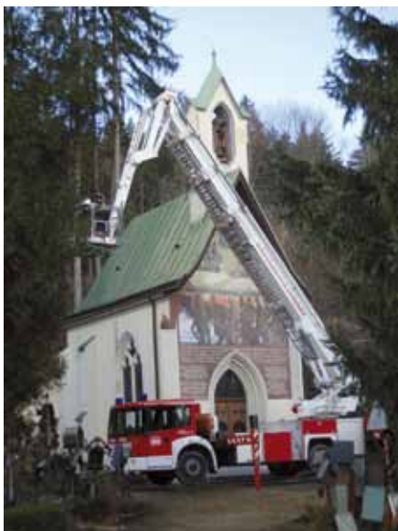
Renovierungsarbeiten mit Feuerwehrunterstützung
