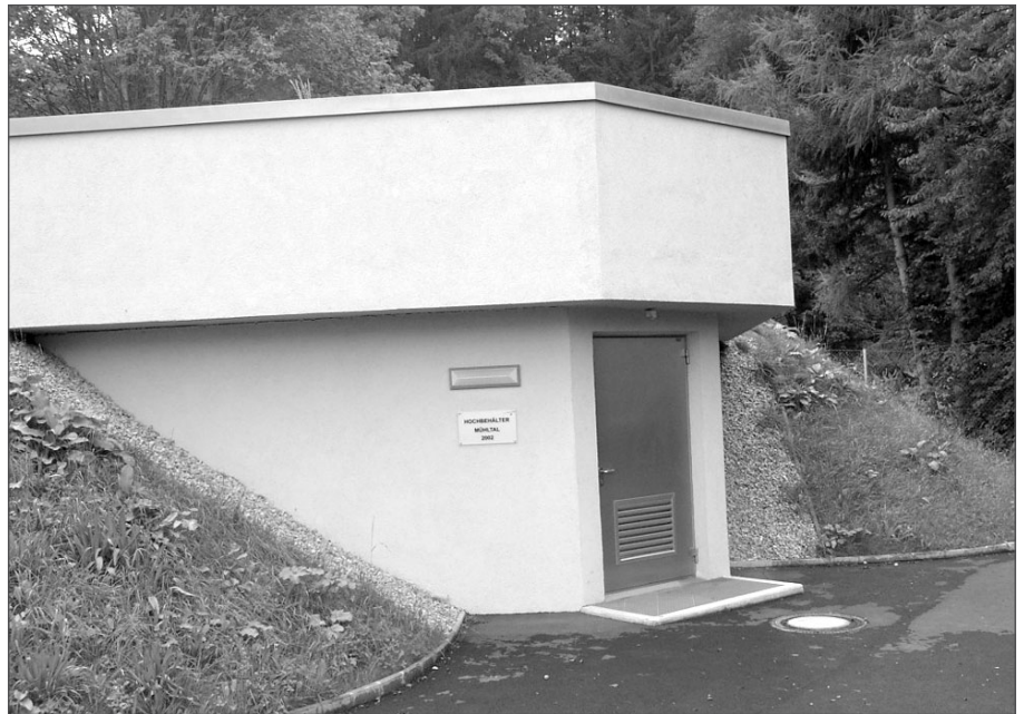
Die 1907 von der Gemeinde Amras erbaute Hochbehälter bei der Mühlthalquellfassung, welcher 2002 von den IKBAG baulich erneuert wurde.
