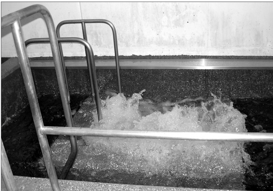
Fassung des hochqualitativen Schreierbachquellenwassers, welches von der Unterseite einer Felsstufe aus Altkristallin entspringt.
